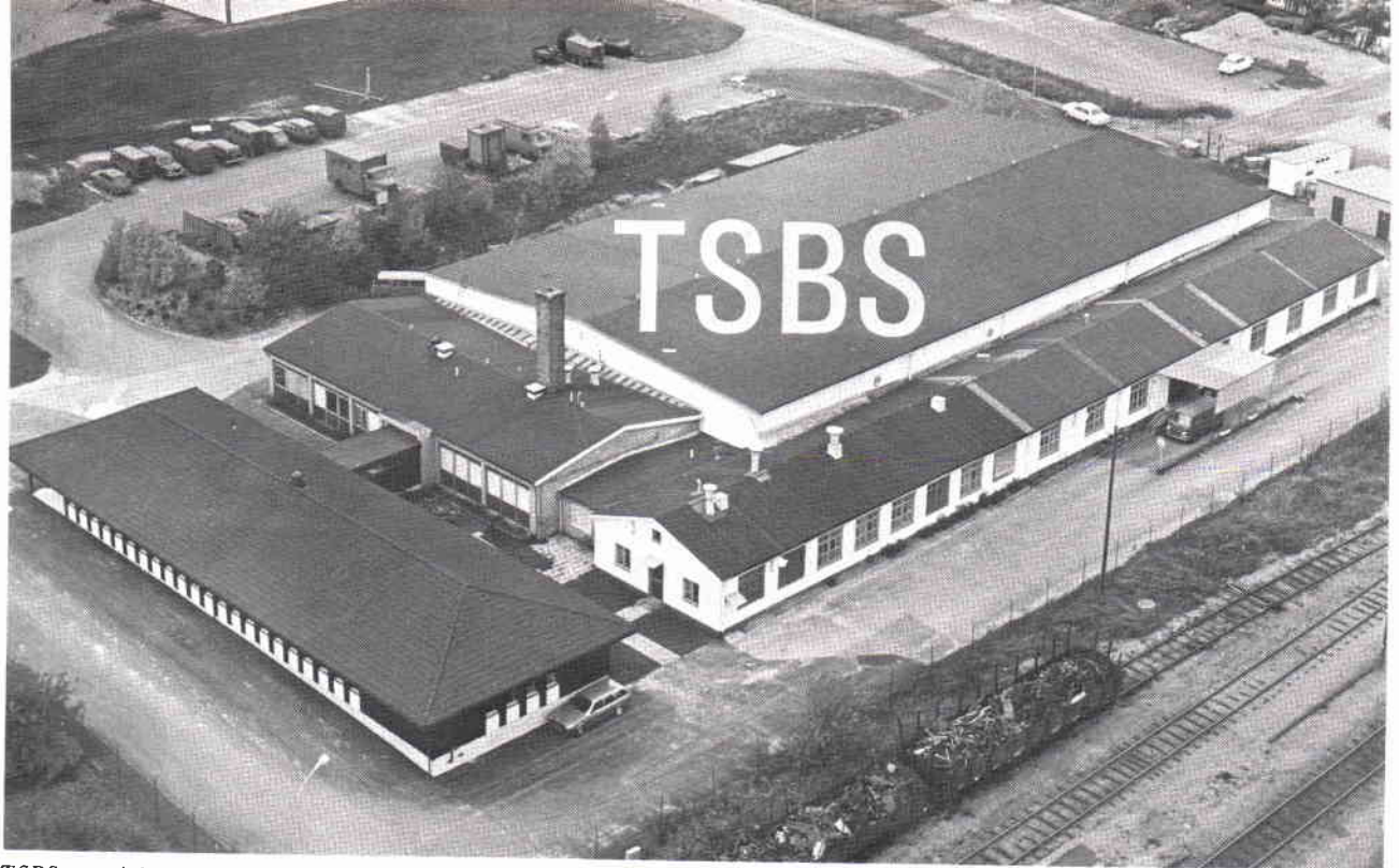
TSBS sett från luften med den tillbyggda kontorsbyggnaden i förgrunden.
